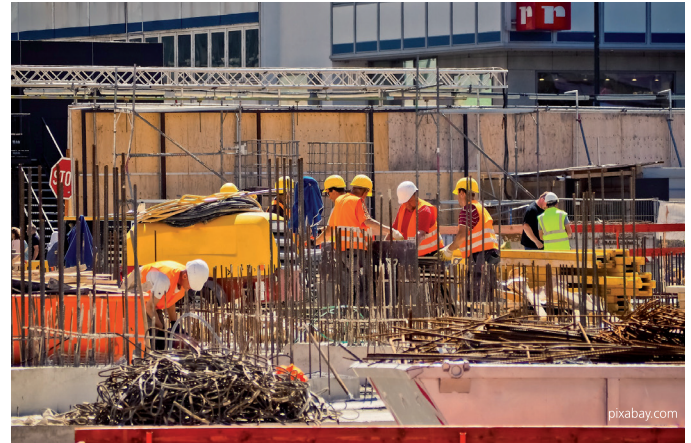
Hochbauarbeiter Beton- und Stahlbetonarbeiten
